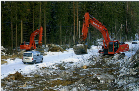
Maanrakennustyöt käynnistyivät Ruotsula-Säyrylä -tiellä.
