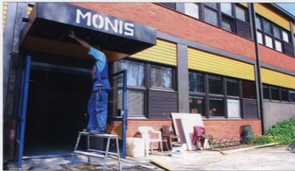
Monitoimitalossa tehtiin remonttia Kaipolassa.
